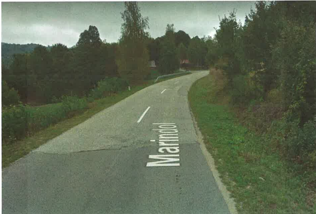
Slika 5: Začetek odseka pri stacionaži 4.870 m.
