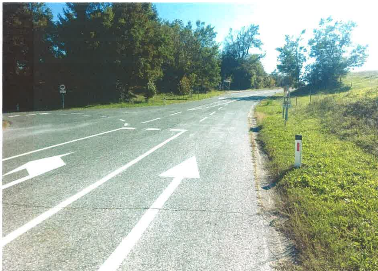
Slika 10: Konec odseka pri stacionaži 8.700 m
